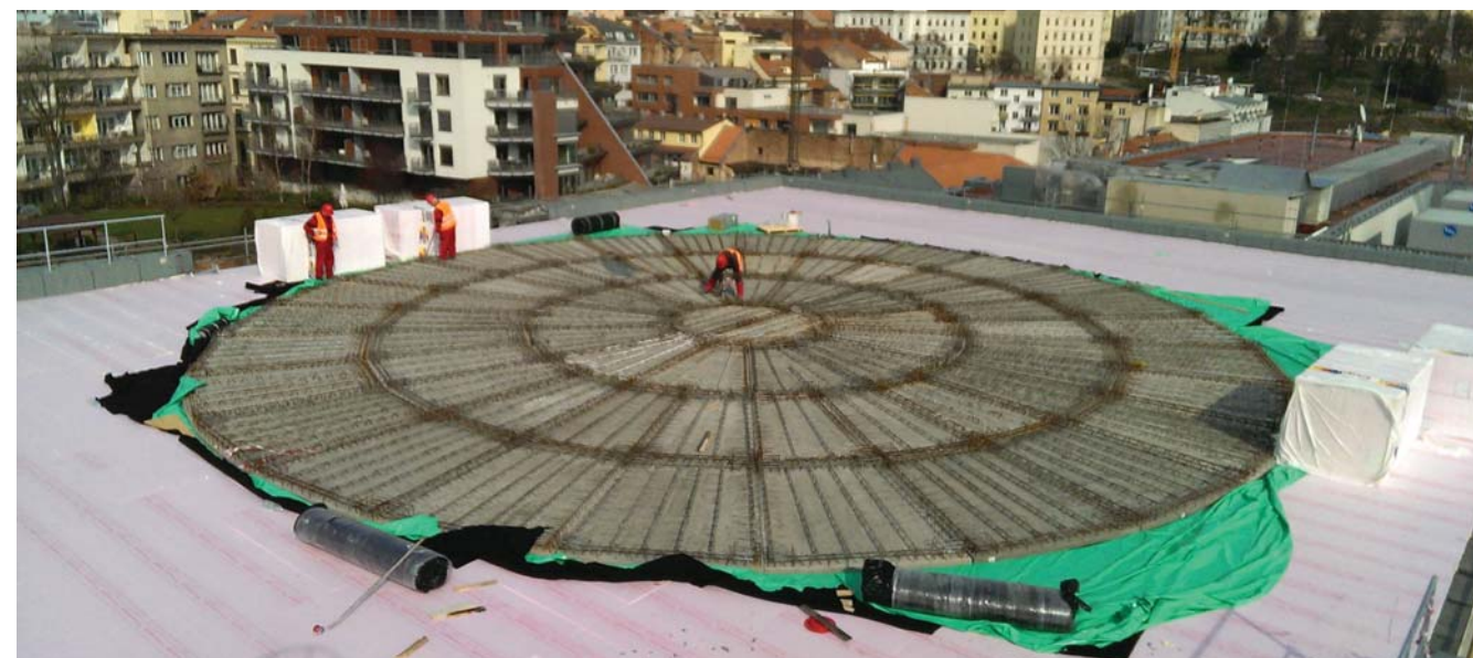
Strop složený z panelů FILIGRAN
